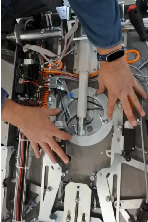
Abb. 29.5 - oberes Fahrwerk lockern
