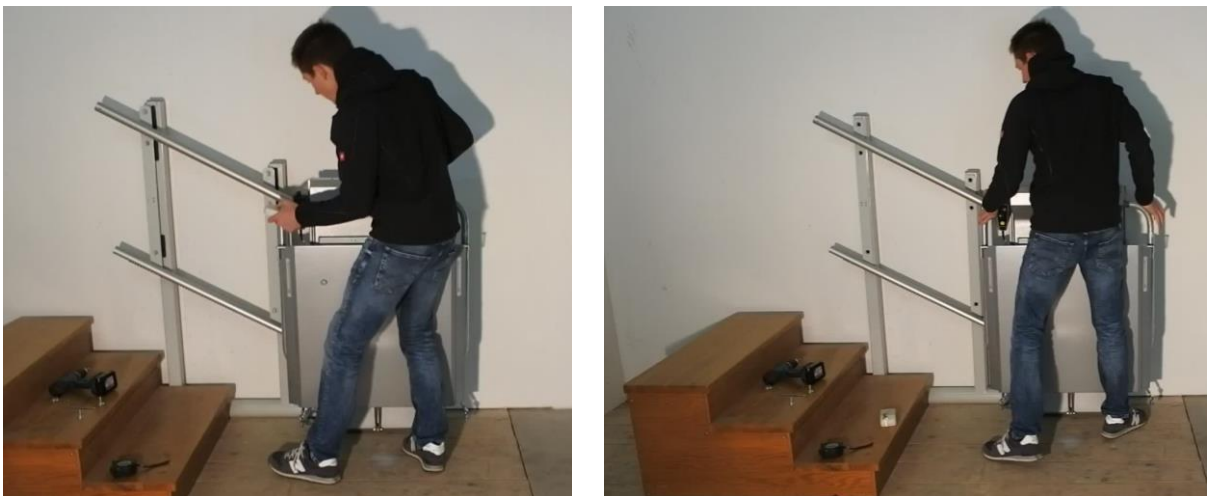
Abb. 9.4 - Plattform einhängen in der unteren Position
