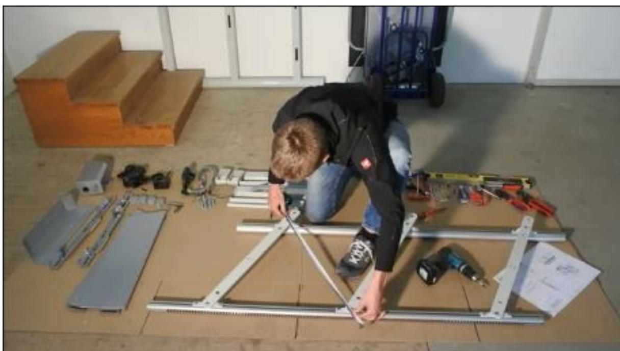
Fig. 5.1 - Montaje del raíl de aluminio según plano
