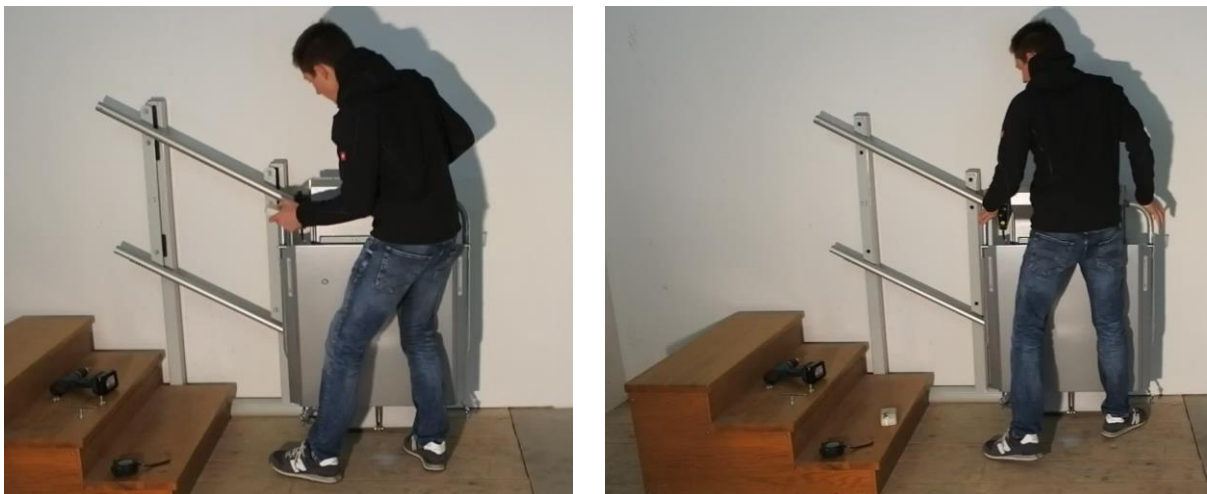
Fig. 9.4 - Accrocher la plateforme dans la position inférieure
