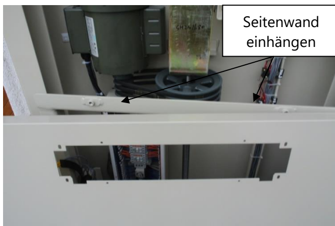
Abb. 3.7 - Seitenwand einhängen
