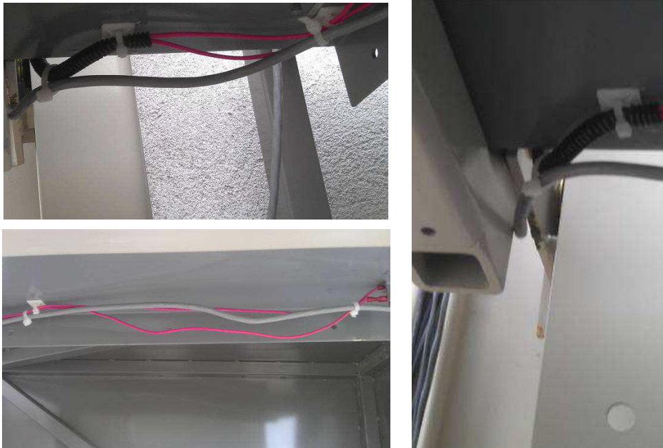
Abb. 3.21 - Anschlusskabel verlegen
