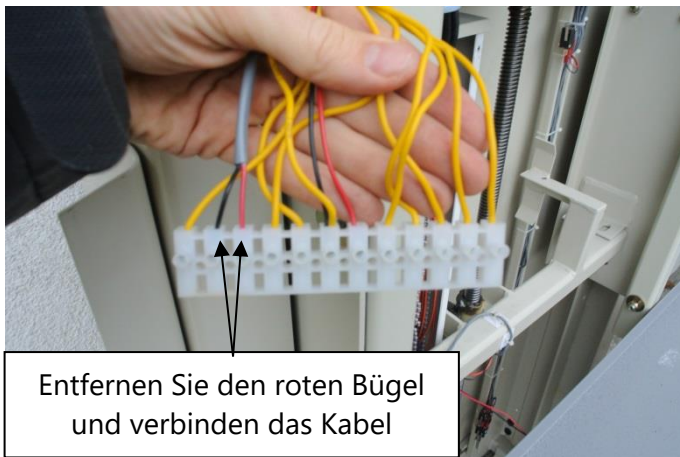
Abb. 3.5 - Kabelverbindung
