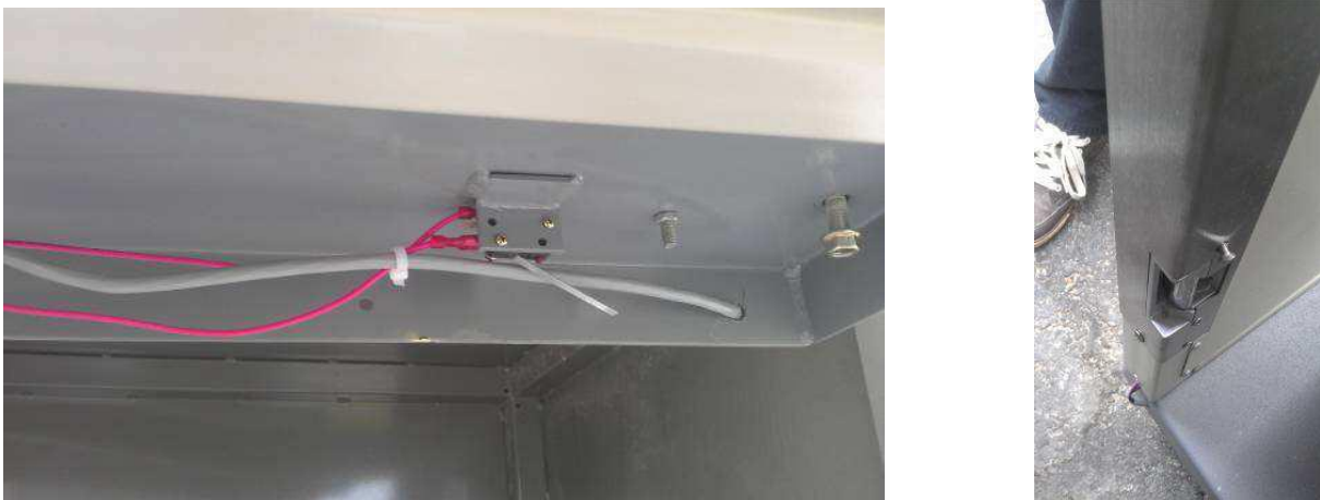
Abb. 3.22 - Anschlusskabel einziehen
