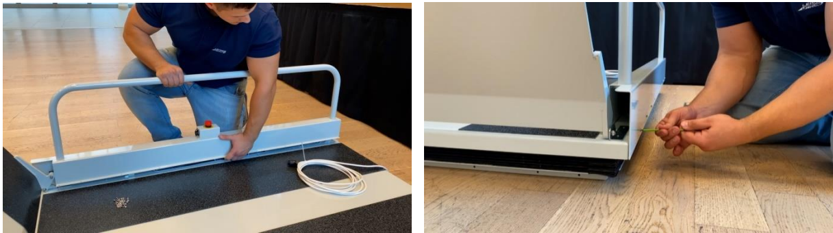
Fig. 5.5 - Montaje de las barreras laterales y cableado
